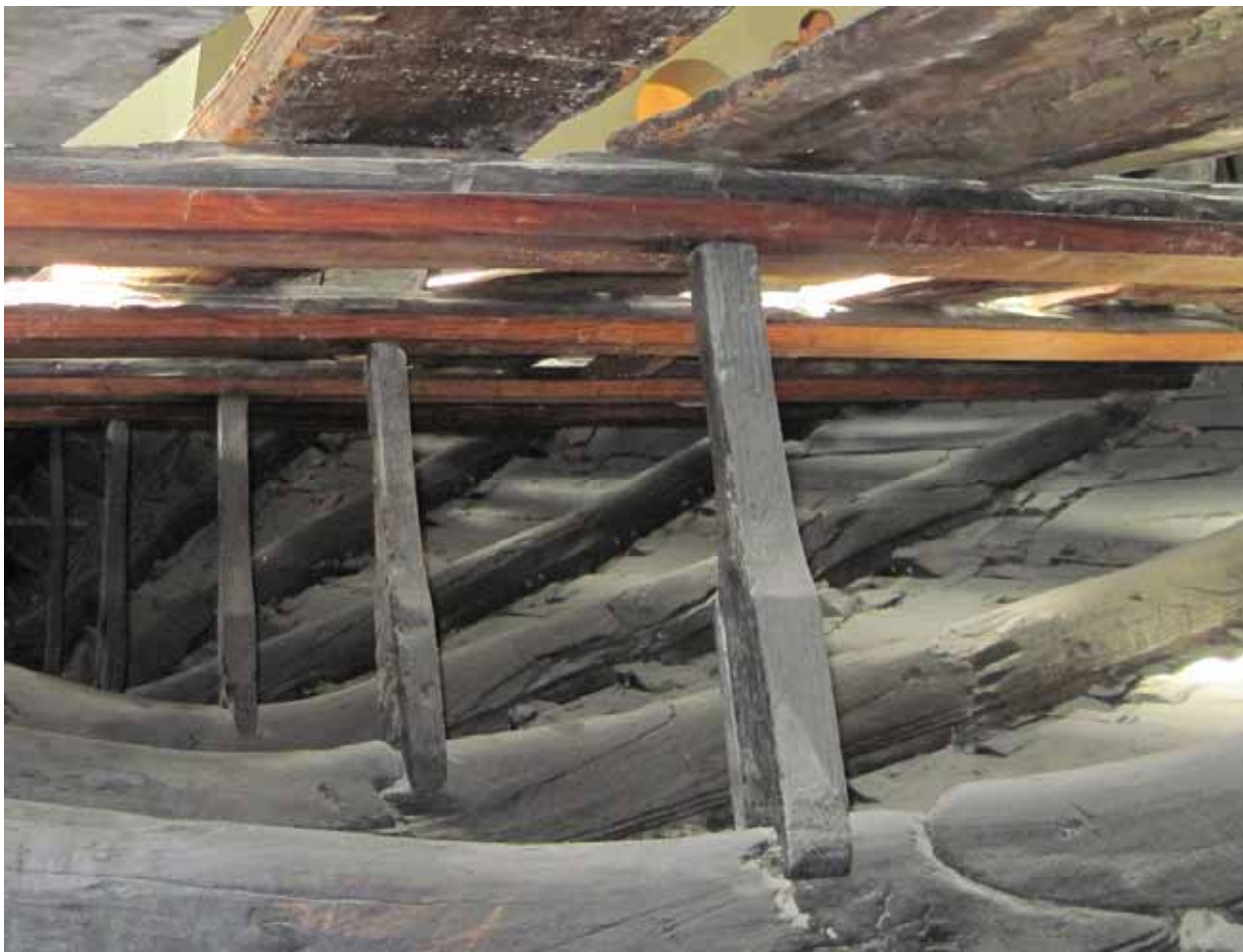
Fig. 6.20. Snellerne står som lodrette støtter mellem bundstokkene og biterne. Foto forfatteren.
