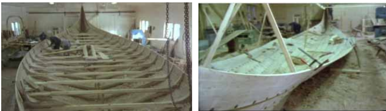
Fig. 6.8. Screen dump fra video af byggeriet af Dronningen . Det fremgår at skibets bord er spinkle. Video: Bertram Schloss og Nadine Pressl, Volda University College.
