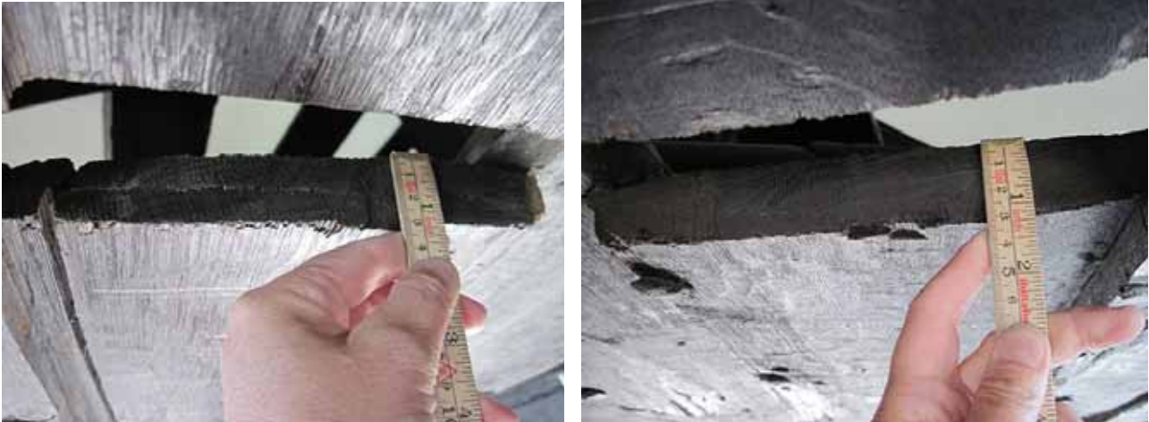
Fig. 4.9. Bordenes tykkelse kunne måles i åbne flækker samt de steder i bordene, hvor der er udtaget prøver til årringsdatering. Foto forfatteren.
