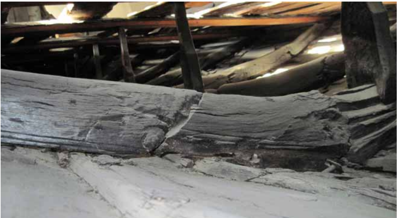
Fig. 4.14. Enkelte af bundstokkene i det udstillede skib er samlet af dele, der ikke har siddet sammen oprindeligt. Bemærk profilen langs bundstokkens underkant. Foto forfatteren.
