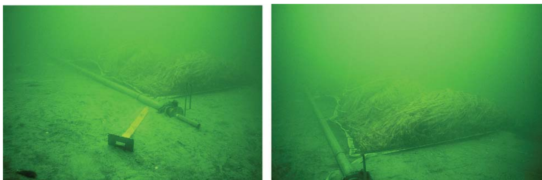
Figur 7: Til venstre ses en af de seks ankerplader, som fastholder måtten på havbunden. Til højre ses måtten udrullet. Græsset holdes nede af sikkerhedsnettet.
