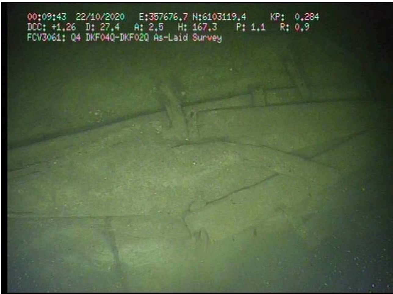
Figur 2: Videostill fra As-laid survey 22-10-2020. På tværs en planke med tilsyneladende fastsiddende spantelementer/lønningsstøtter. Figur 2 Video: Fugro/Vattenfall.
