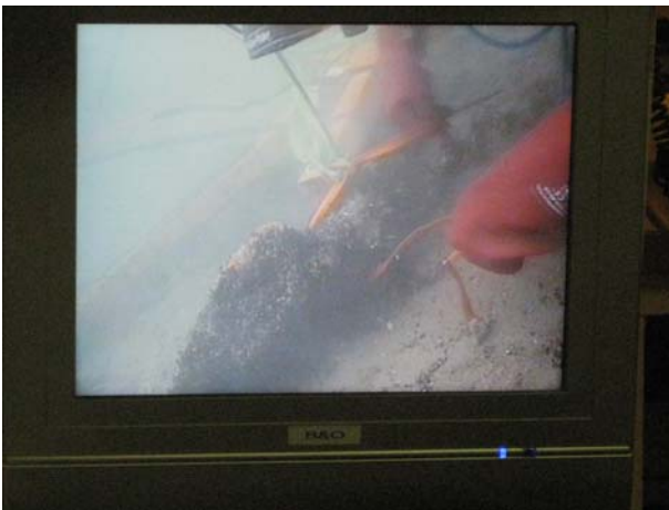
Fig. 4. Fastgørelse af ankeret til løfterammen og løft fra havbunden (Foto: Jørgen Dencker, Vikingskibsmuseet/JD Contractor A/S)
