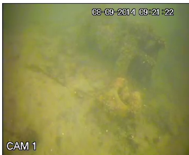
5. Ankerspil og pumpebrønd
