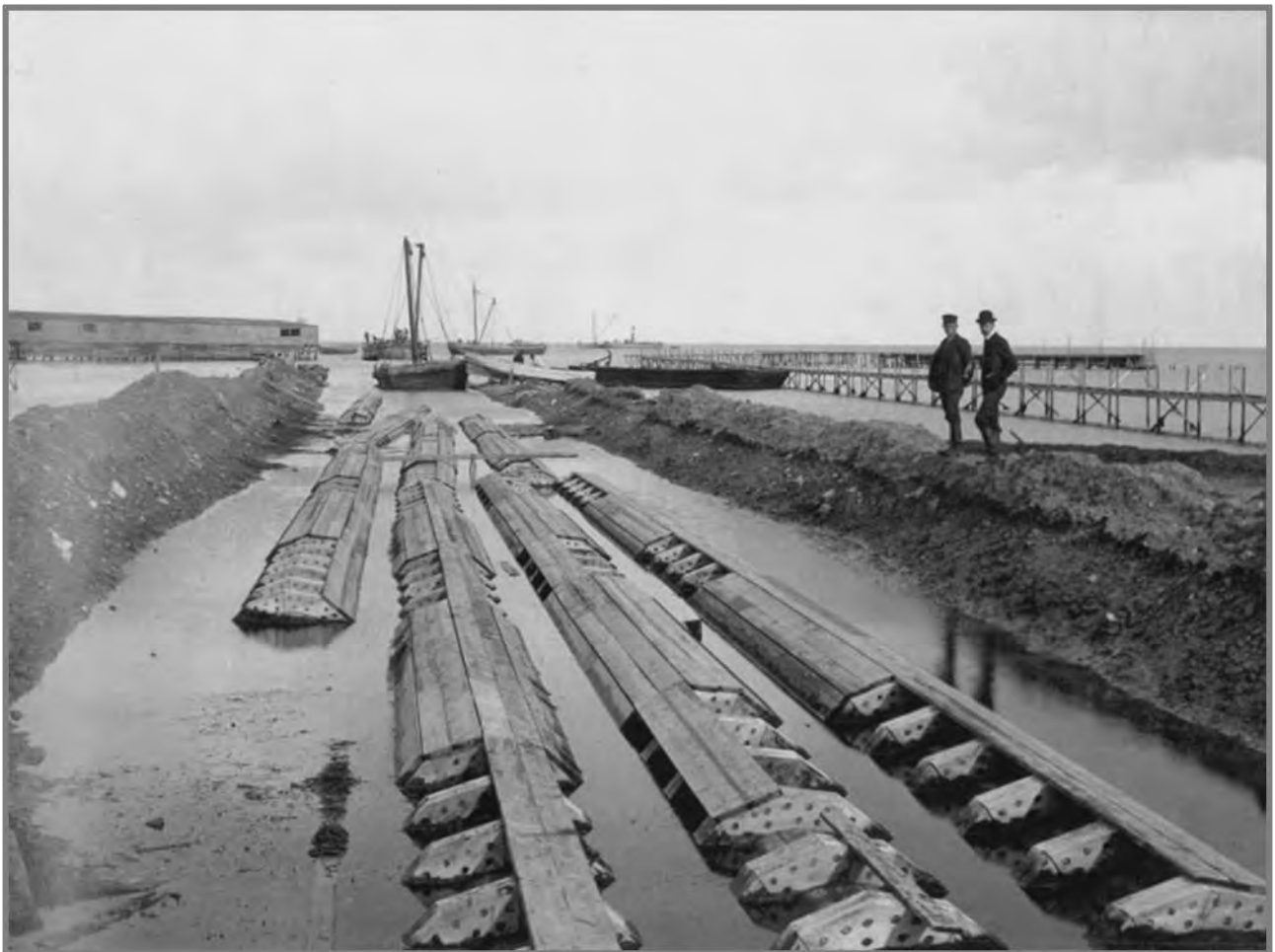
Figur 3: Kloakrøret under konstruktion i Svanemøllebugten 1906 (Eriksen 2007)
